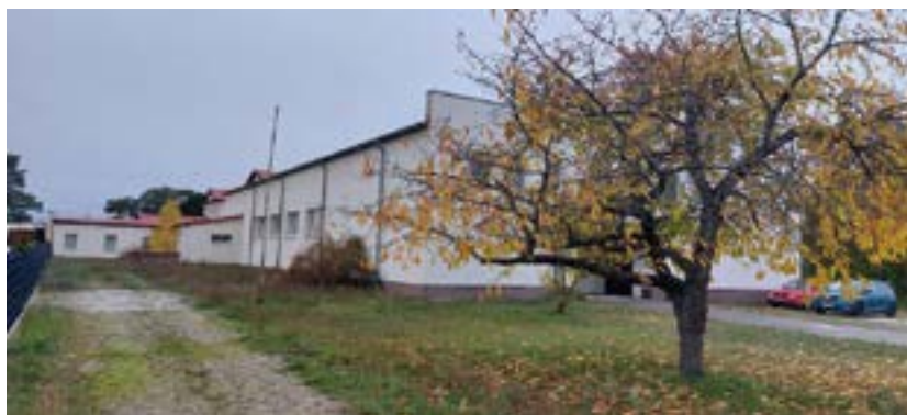
Südansicht – Bereich Saal
